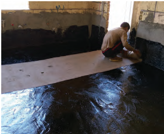
شکل ۱۱-۴- اجرای قیرگونی کف فضای داخلی
