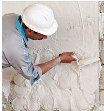
شکل ۱۶-۴- جزئیات نحوه ماله‌کشی و شمشه‌گیری اندود گچی دیوار
