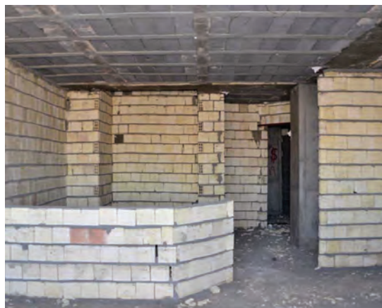
شکل ۴-۴- تیغه چینی داخلی با بلوک سفالی
