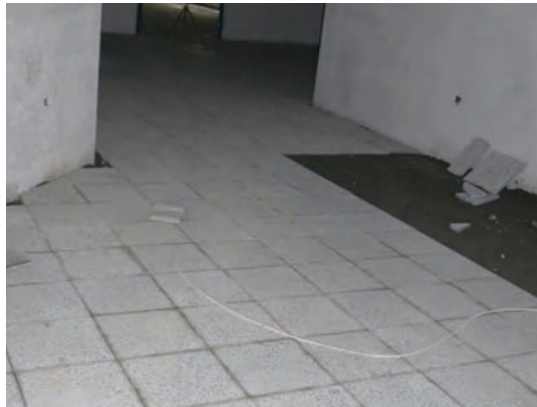
شکل ۲۷-۴- اجرای کف موزائیک در داخل ساختمان
